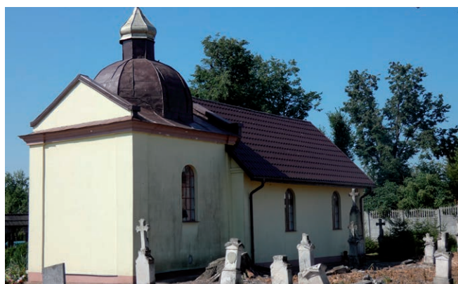
Kaplica cmentarna w Podlodowie – Rzeczycy, obecnie kaplica filialna p.w. św. Huberta
