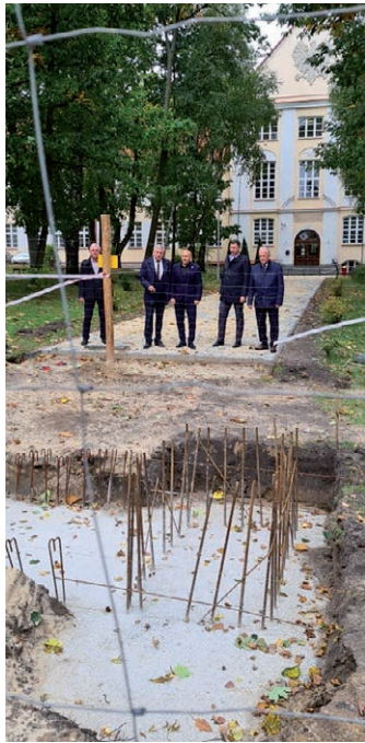
21 września 2021 r. Rozpoczęcie budowy Łuku Żwycięstwa
