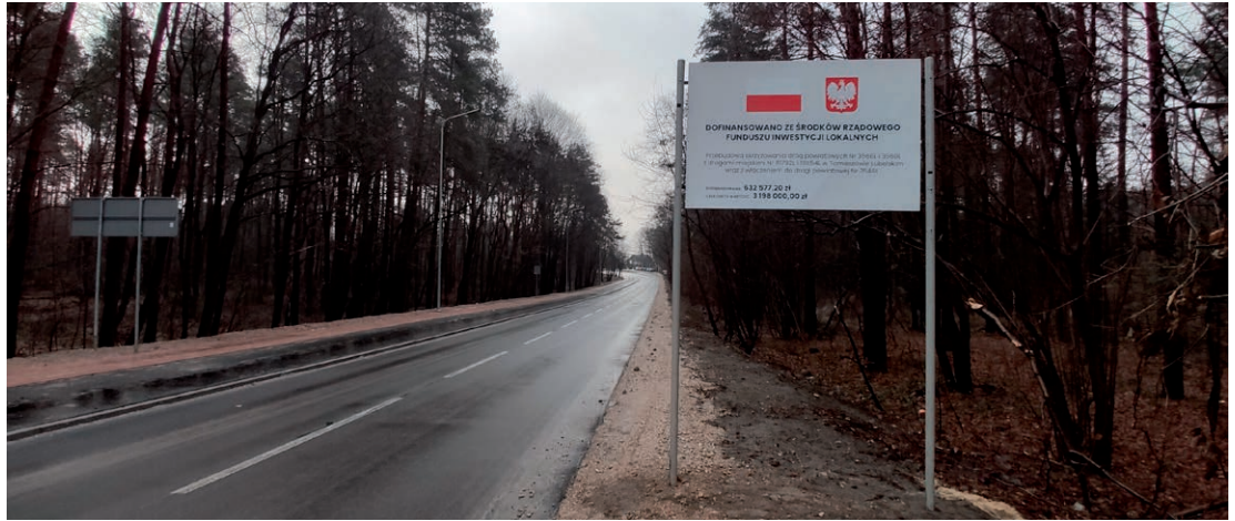
Przebudowa ulicy Ordynackiej w Tomaszowie Lubelskim
