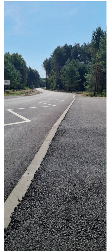
30 czerwca 2022 r. odbiór drogi Mazily-Podlesina
