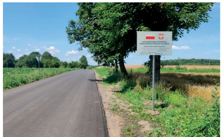
Przebudowa drogi na odcinku Steniatyn - Rokitno - 3 651 530,79
