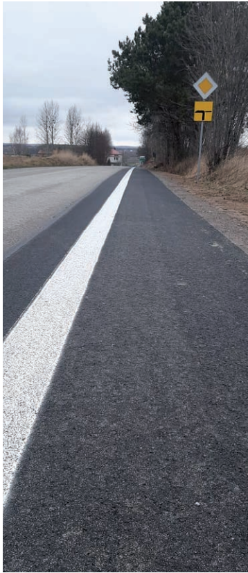
28 grudnia 2021 r. odbiór końcowy drogi Zamiany- Szarowola
