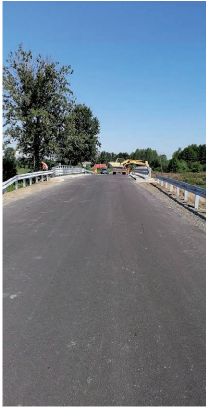
Przebudowa mostu na rzece Szyszła - 884 150,81 zł
