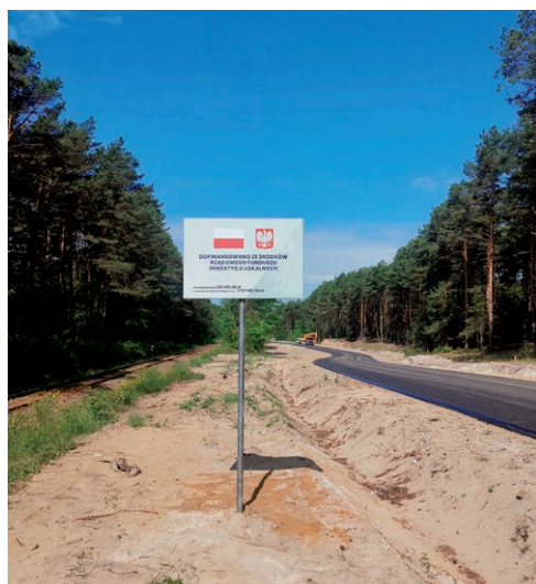
Budowa drogi powiatowej w miejscowości Podlesina od granicy województwa do miejscowości Mazły - 1 757 107,97 zł
