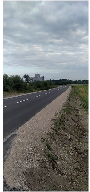
Remont drogi powiatowej na odcinku Lubycza Krolewska - Szalenik - 1 587 826,63 zł
