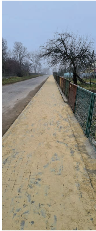
Budowa chodnika przy drodze powiatowej Chodywańce - Plebanka
