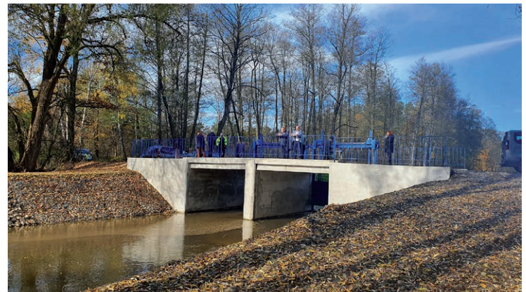
28 października 2022 r. remont - Leliszka
