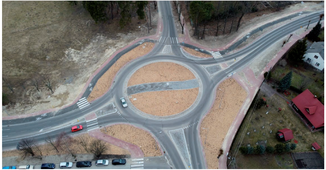
Przebudowa skrzyżowania ulic Ordynackiej, Żwirki i Wigury i Alei Sportowej w Tomaszowie Lubelskim - 3 198 000,00 zł
